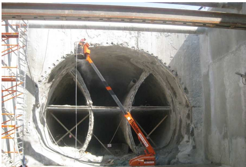
Obrázek 5: Možné členění výrubu při ražbě v neogenních jílech (foto Královopolský tunel)
